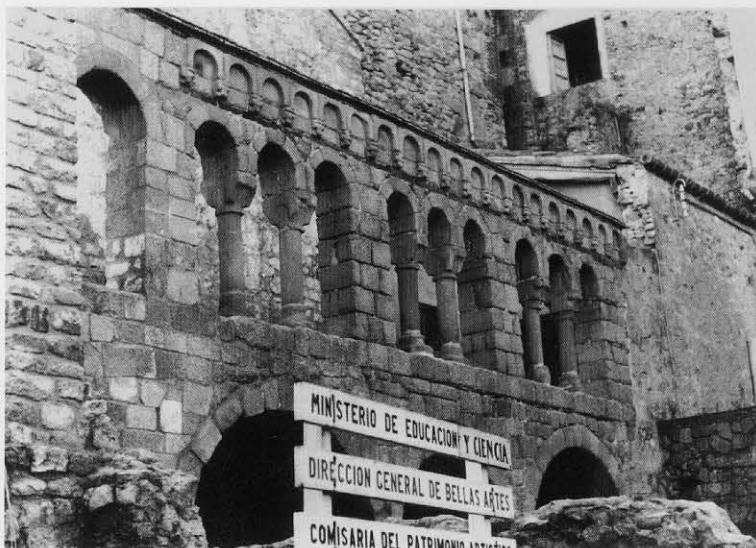
Obres de restauració a la Porta Ferrada, anys 60
