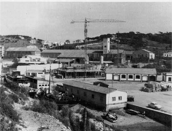
Comencen les obres de l'edifici Joan I, 1967
