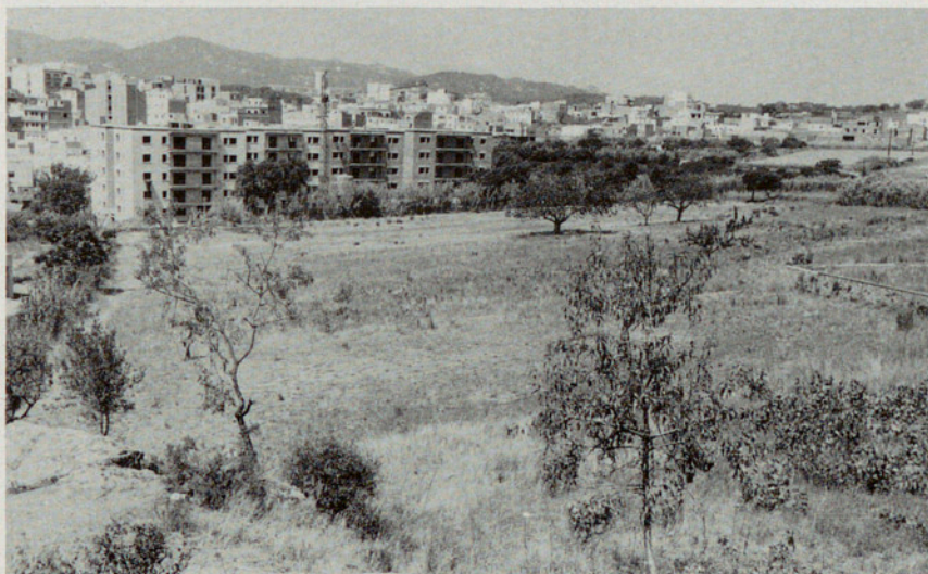
Solar on s'hi construiria l'escola pública de Vilartagues. El 1975 començaren les obres.
