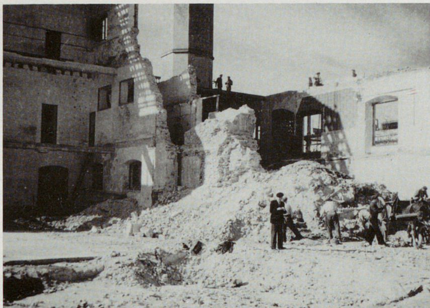
El 22 de gener fou bombardejat l'antic edifici de les escoles nacionals. Després s'acabà d'ensorrar per poder-hi reconstruir l'Ajuntament.
