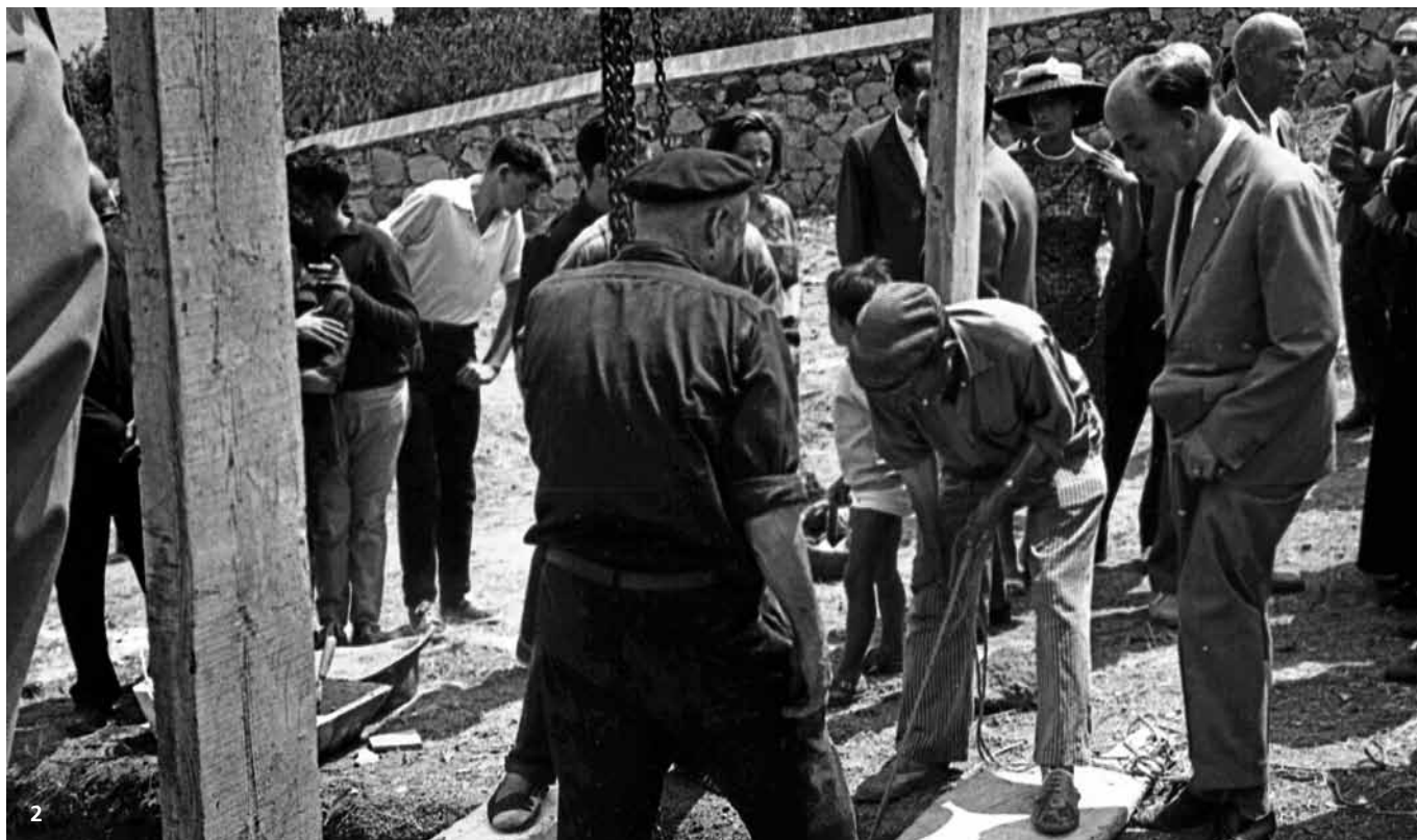
2. Detall de l'acte de col·locació de la primera pedra de l'edifici del Liceu Abat Sunyer, actual Institut Sant Elm, el 25 de juliol de 1963. AMSFG. Fons Jordi Budó. (Autor: Jordi Budó) 3. Acte d'inauguració oficial de l'edifici del Liceu Abat Sunyer el dia 14 d'octubre de 1965. AMSFG. Fons Jordi Budó. (Autor: Jordi Budó)
