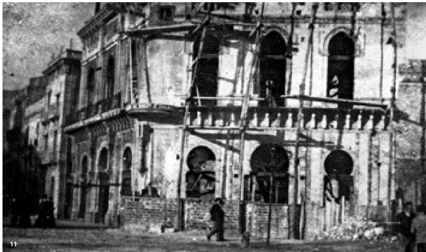
11. Vista de la façana del Casino La Constància amb una bastida l'any 1900, durant les obres d'ampliació. AMSFG. Col·lecció Municipal d'imatges (Autor: desconegut) 12. Desfilada de Carnaval al passeig del Mar, probablement la fotografia correspon a la desfilada de l'any 1934. AMSFG. Col·lecció Espuña-Ibáñez. (Autor: Josep Manetes)
