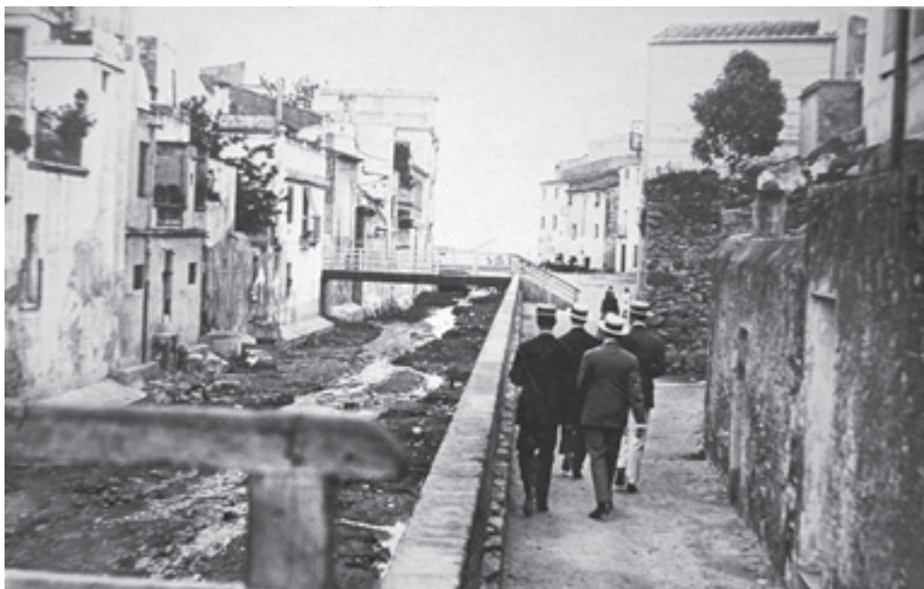
Carrer de la Riera (actual av. Juli Garreta) abans d'urbanitzar-se. Guitart ja va preveure l'any 1897 el cobriment del torrent.
