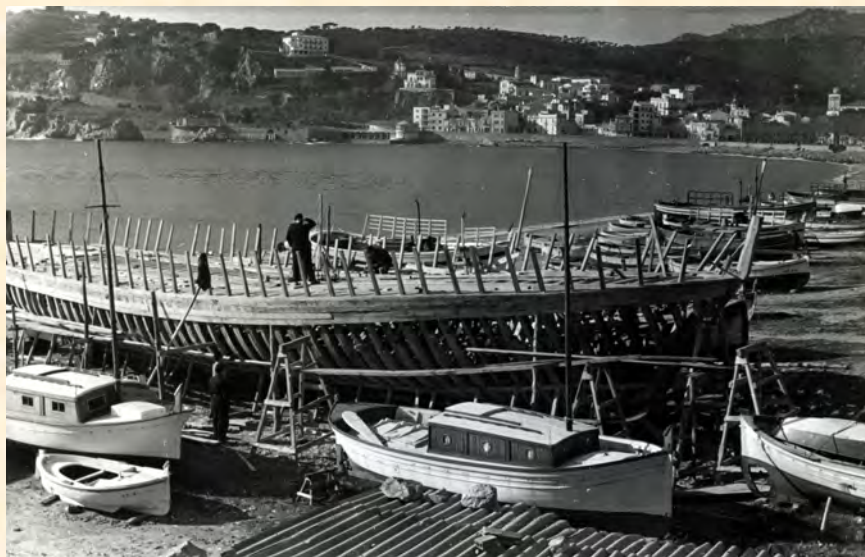
Construcció del creuer Pasajes Costa Brava per Ramon Gay al racó de Llevant, 1957-1958 (AMSFG. Col. Municipal Imatges. Autor desconegut)
