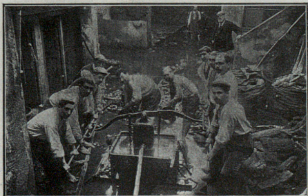
Obreros de la fábrica de tapones del señor Miró, extrayendo el agua del calle principal después de la inundación.
