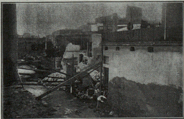
Casa Correos derrumbada por la corriente sin que afortunadamente produjera desgracia ninguna.
