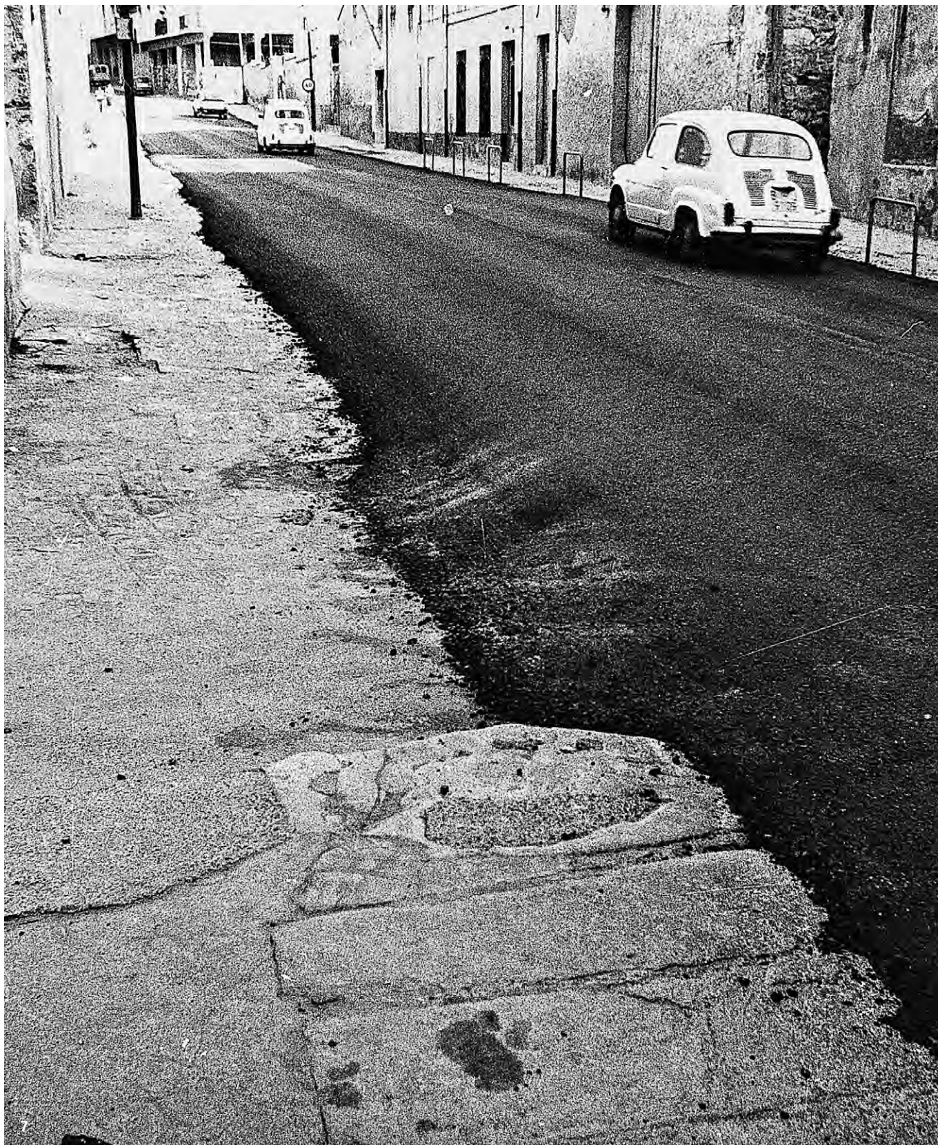
7. Carretera de Palamós acabada d'asfaltar, el 24 de novembre de 1982. AMSFG. Fons El Punt Diari (autoria: Antoni Dalmau)
