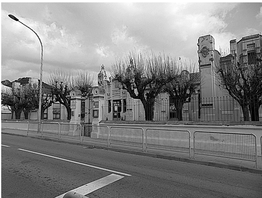
Vista general de l'escola Sant Cristòfol de les Planes d'Hostoles, obra de Joan Roca Pinet el 1911, la reforma i ampliació de la qual fou projectada per Jordi Bosch i Joan Tarrús el 1980. Procedència: Wikimedia Commons (autoria: Josep Maria Viñolas Esteva)
